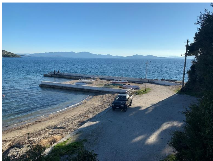
Σχήμα 7: Άποψη της ράμπας ανέλκυσης – καθέλκυσης και των δύο εκατέρωθεν βραχιόνων
