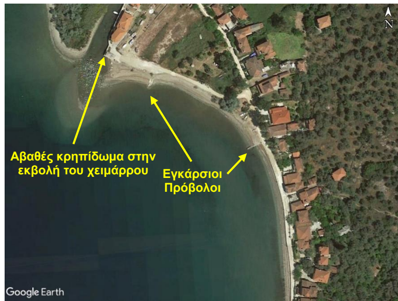
Σχήμα 2: Υφιστάμενα παράκτια έργα έμπροσθεν του οικισμού Καλάμου (πηγή: Google Earth)
