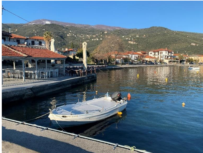
Σχήμα 12: Άποψη τμήματος του παραλιακού κρηπιδώματος του καταφυγίου
