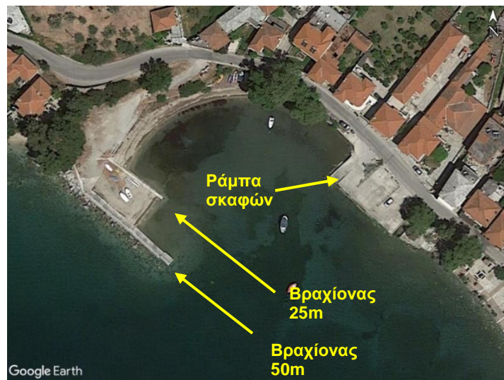
Σχήμα 5: Το καταφύγιο σκαφών στην Αφήσσο (πηγή: Google Earth).
